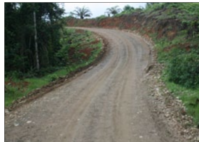
Vía Wimbitico-Wimbi lastrada en 10 km
