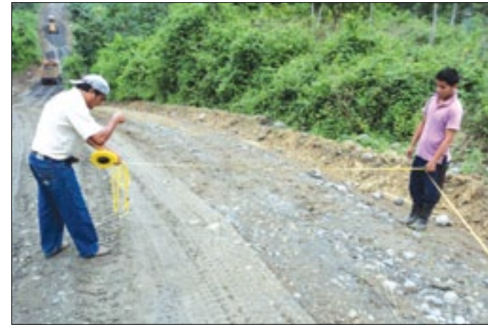
7km de vía lastrada por la Prefectura de Esmeraldas
