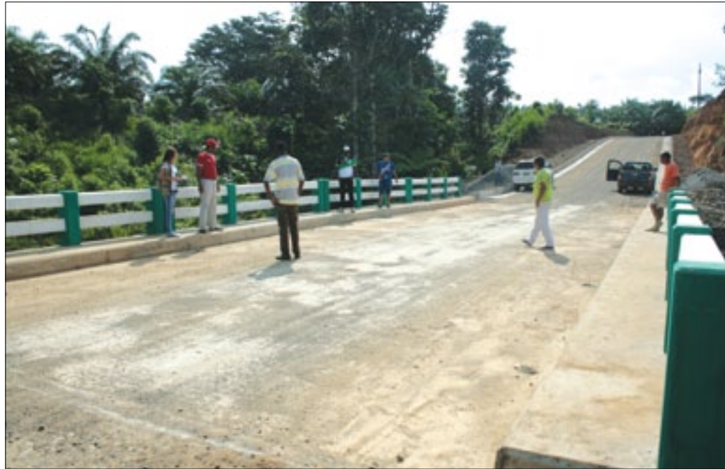
Puente sobre el río Sabalito-Quinindé
