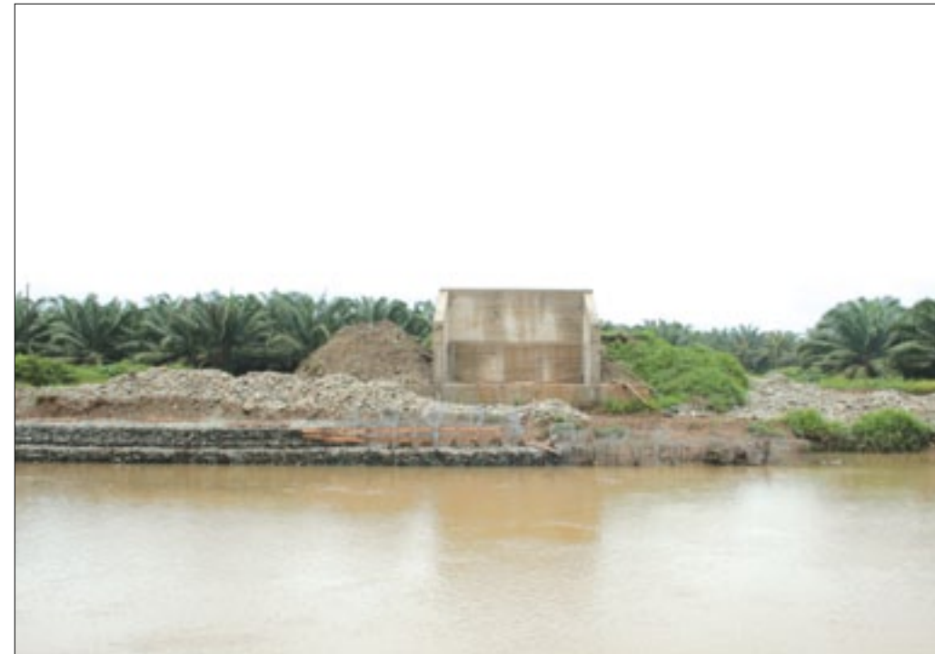
Río Bogotá sobre el cual se construye el puente de 82M
