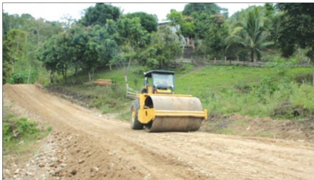
Maquinaria de Prefectura realizando lastrado de la vía Lagarto-Pajuí
