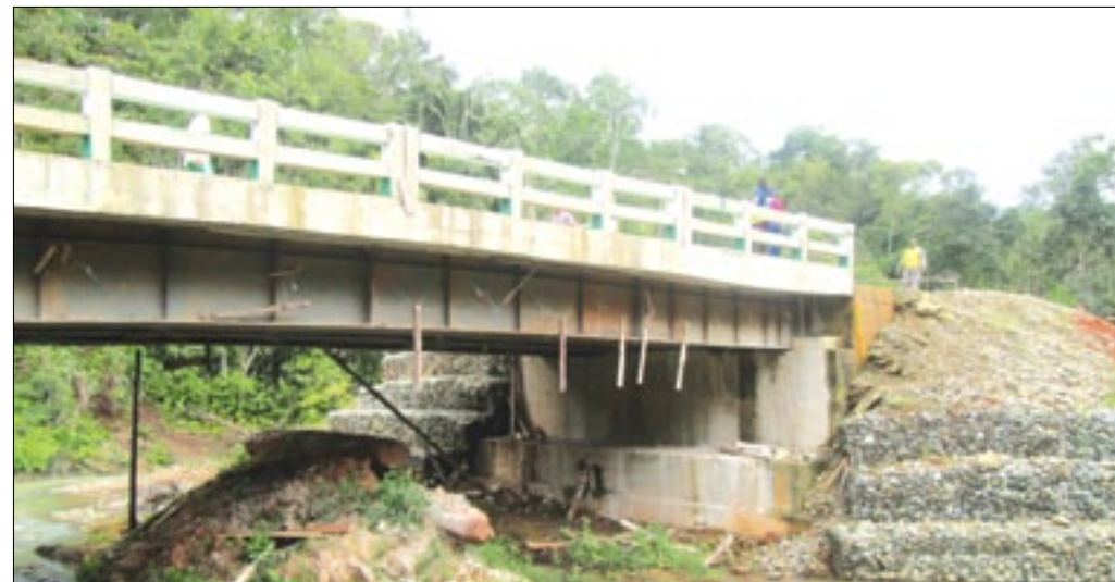
Puente sobre el río Sabalera, una obra para más de 40 años de servicio
