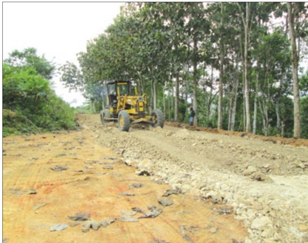
Maquinaria efectúa labores de cascoteo en la vía Hoja Blanca-San Francisco del Ónzole
