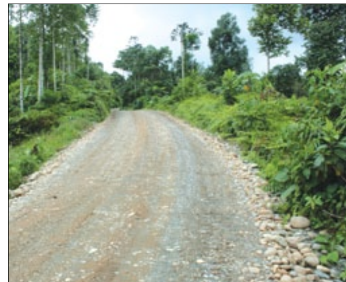
Vía Juan Montalvo-"Aquí me Quedo" lastrada en 10 km
