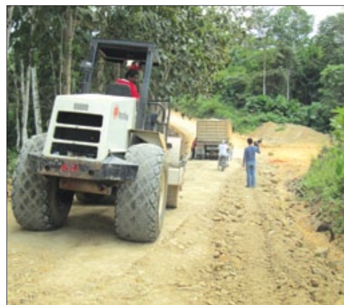
Obreros aceleran trabajos viales
