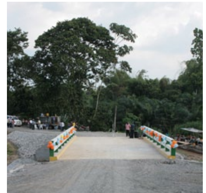
Puente sobre el río Dotrino-Malimpia-Quinindé
