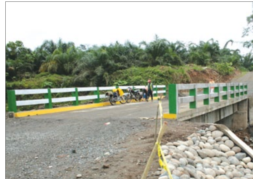
Varios puentes que se construyen en Quinindé se encuentran en etapa final
