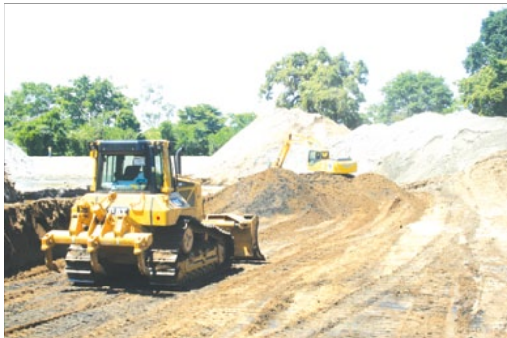
Maquinaria de la Prefectura en labores de mantenimiento vía la Tola-Garrapata
