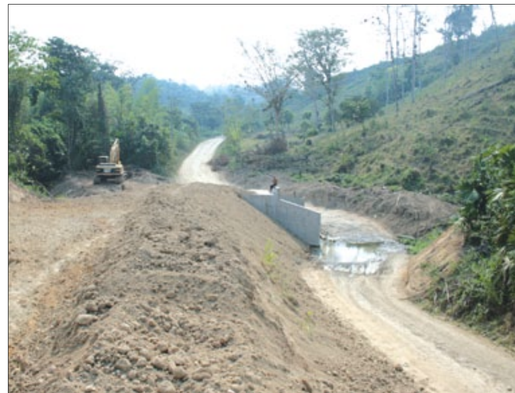
Se construyen ductos cajon en la vía San Roque-Emilio Huerta-Quinindé
