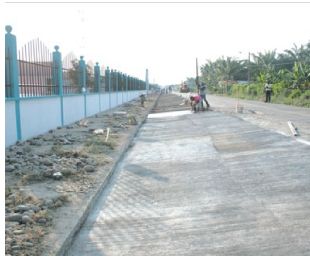
Obreros construyendo cunetas en la vía Unión El Silencio
