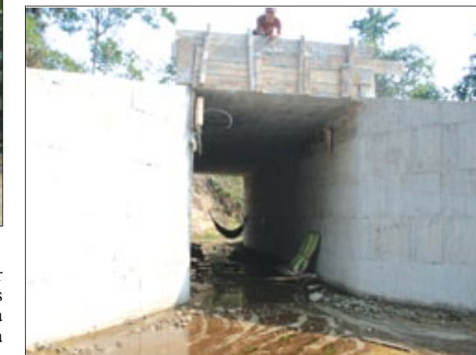
Obras que dan estabilidad y garantía a la vía
