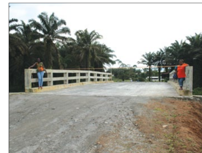
Este puente está ubicado en la vía 10 de Agosto La Independencia
