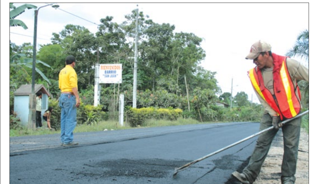
Los obreros aprovecharon el buen clima para efectuar mejor su trabajo
