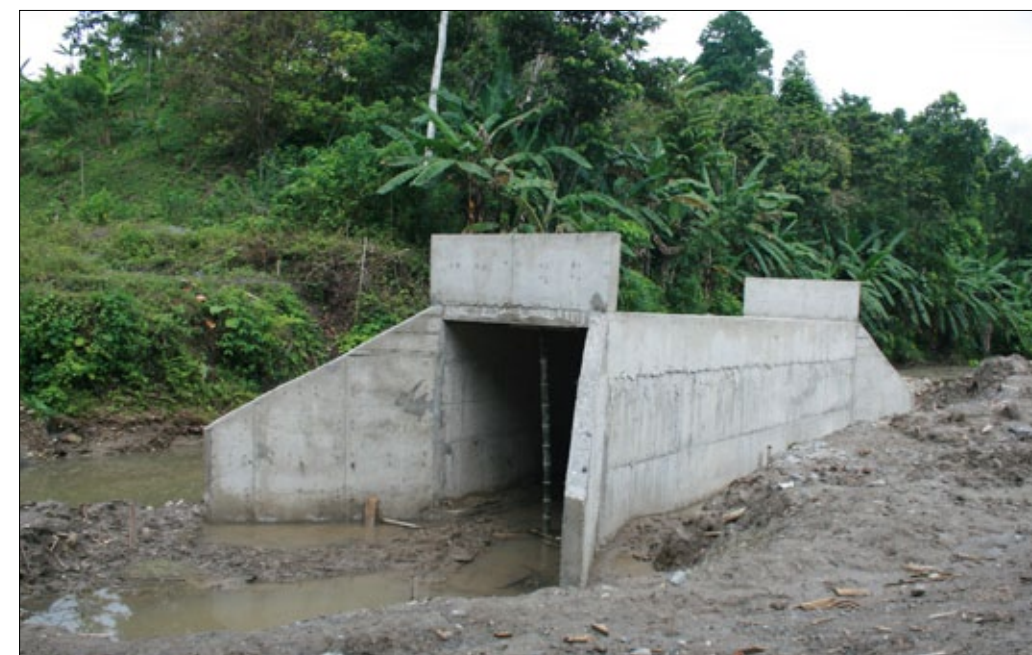
La colocación de ductos cajón darán estabilidad a la vía
