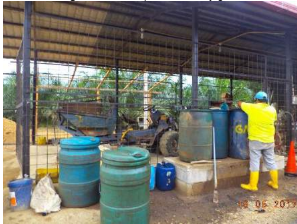
Fotografía 21. Tanque de diésel y gasolina
