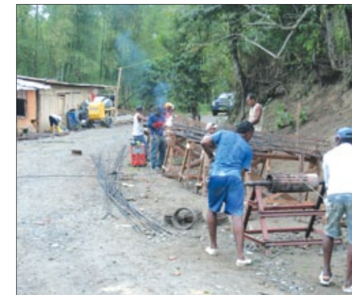
Tejido de estructura previo a la fundición de loza
