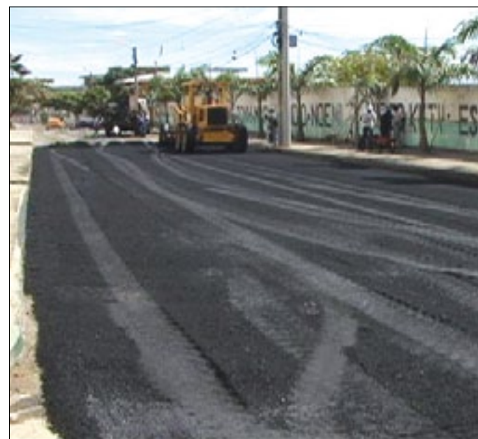
Prefectura y Municipio de Esmeraldas una vez asfaltan calles
