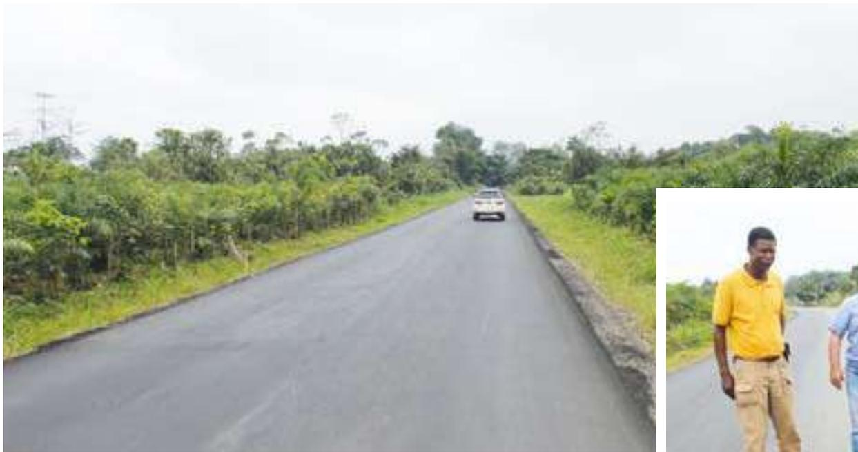
metros de ancho, capa asfáltica de tres pulgadas, cunetas, aceras y bordillos en la zona poblada.
